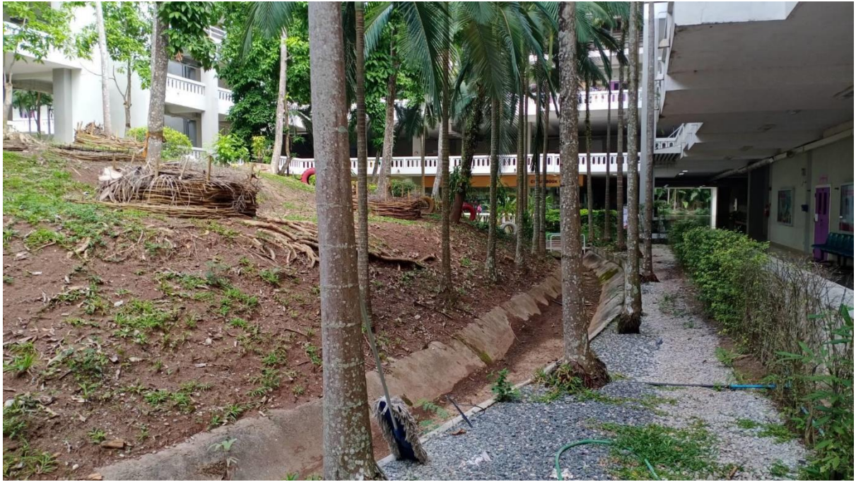
รูปพื้นที่ก่อนดำเนินการปรับปรุงพื้นที่
